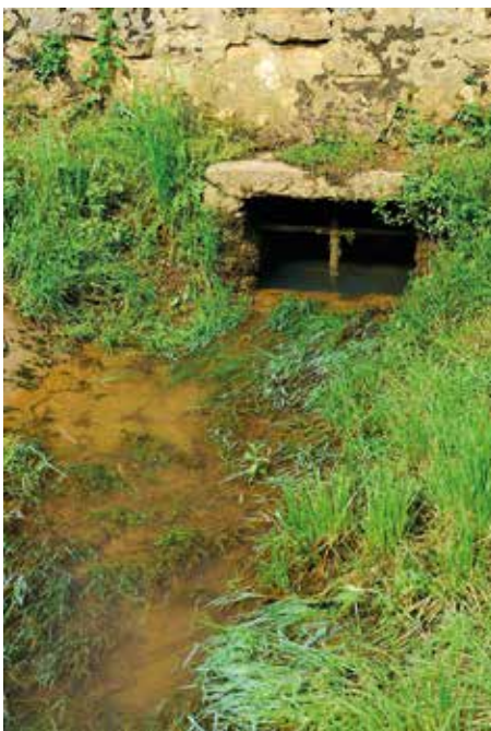
Obzidan izvir Mežnarček pod obrežno škarpo.
