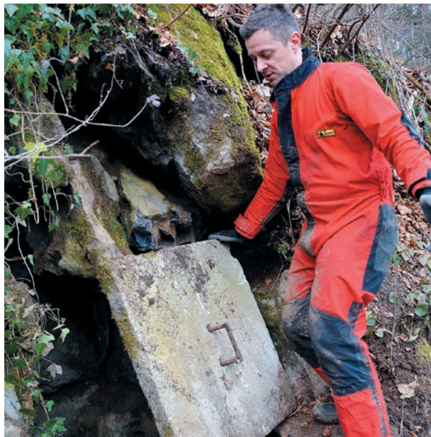
Brezno pri Pihalniku so zaprli s pomočjo betonskega pokrova in pred njim zložili še kamnito škarko.
