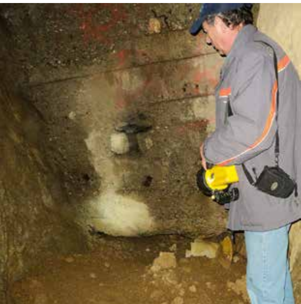
Luknja v betonski pregradi. FOTO BORIVOJ LADIŠIĆ
