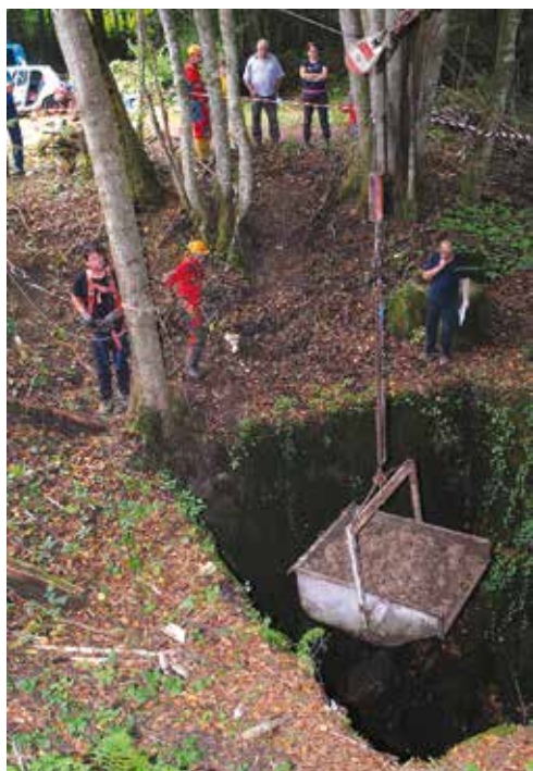
Dvigovanje odpadkov iz vhodnega brezna s pomočjo hiab dvigala, vitla in škripca. Foto TOMAZ BUKOVEC
