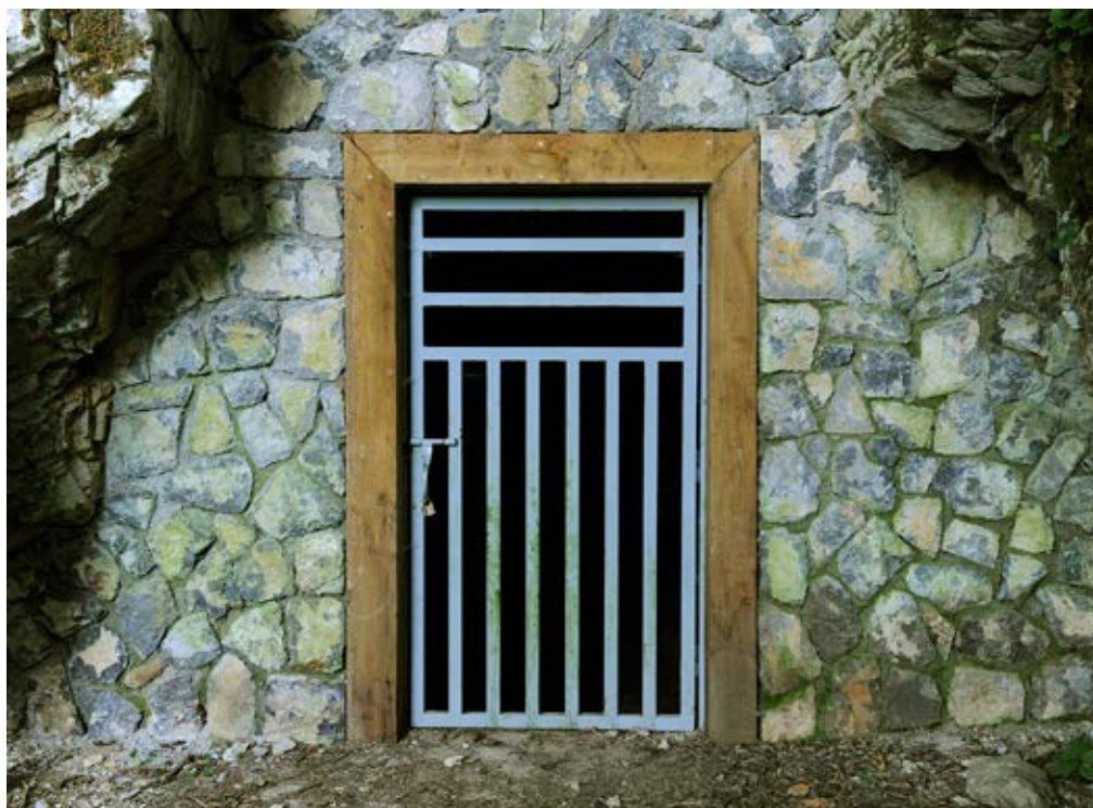
Jazbina – primer optimalnih preletnih razmer: vodoravne prečke so med sabo oddaljene od 13 do 15 cm, navpične pa od 45 do 75 cm. FOTO MARKO PRŠINA
