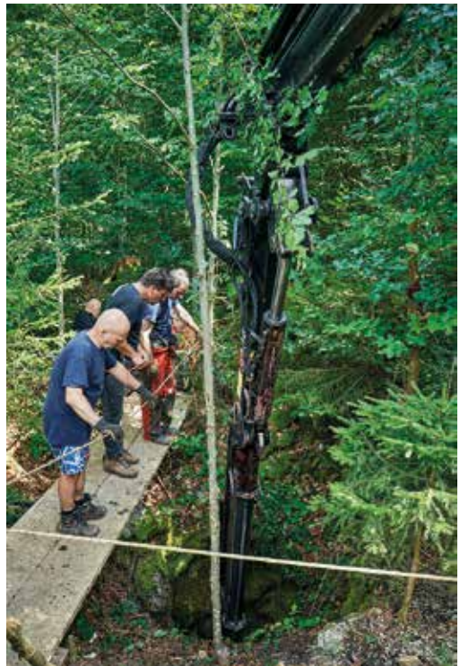
Neizogibna pomoč gradbene mehanizacije.
