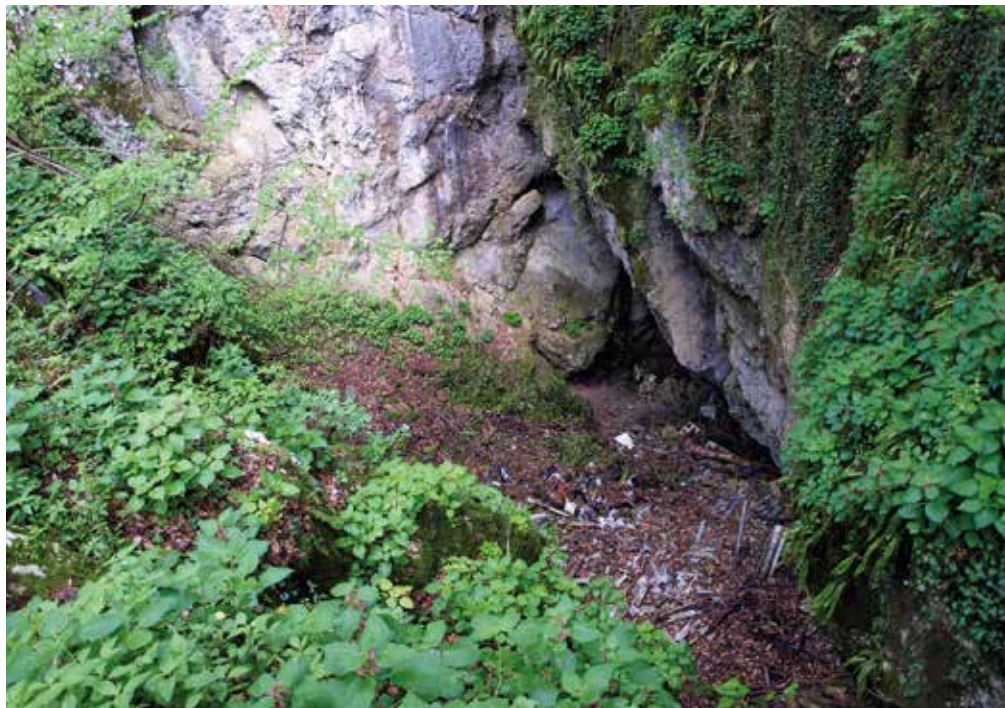
Na dnu Kipine jame (kat. št. 853) pri Bojanji vasi je odložena velika količina gradbenih in komunalnih odpadkov, stanje april 2016. FOTO JURE TIČAR
