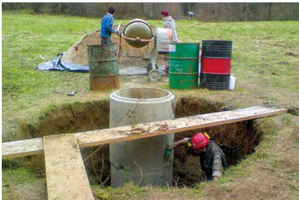
Urejanje vhodnega jaška v podzemni sistem Šice. FOTO DARE HRIBAR
